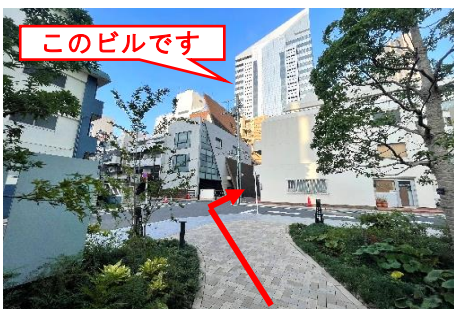
⑩ はぐくみSTAGE(広場)を出ましたら右斜め前の道をお進みください。(正面のビルの1階が学校の入口)
